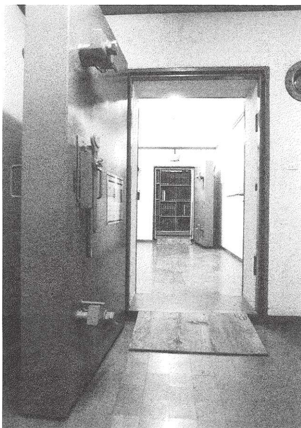
Abb. 12: Eingang zu den Kulturgüterschutzräumen
